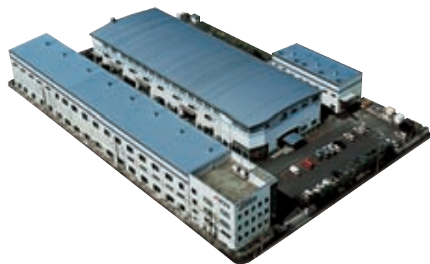
設計、開発、生産拠点 (三田工場)
