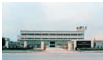
川田機械製造（上海）有限公司
