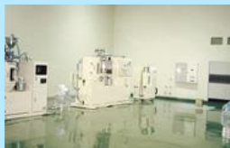
クリーンルーム
