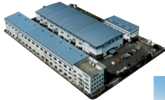
設計、開発、生産拠点 (三田工場)
