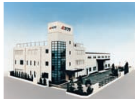
サービス拠点 (東京工場)
