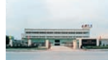
川田機械製造(上海)有限公司
